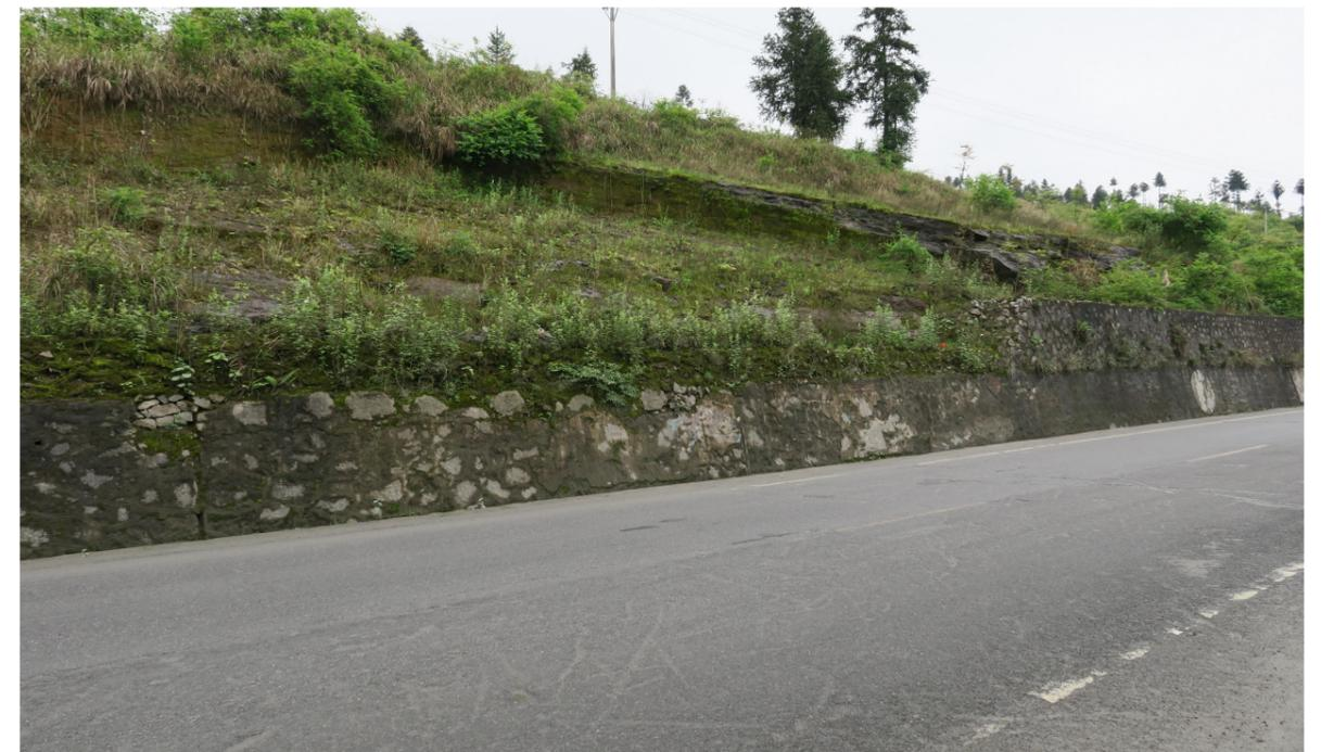
图 4-1-2 东库岸迳大公路开挖边坡挡墙及上部稳定顺层岩体
