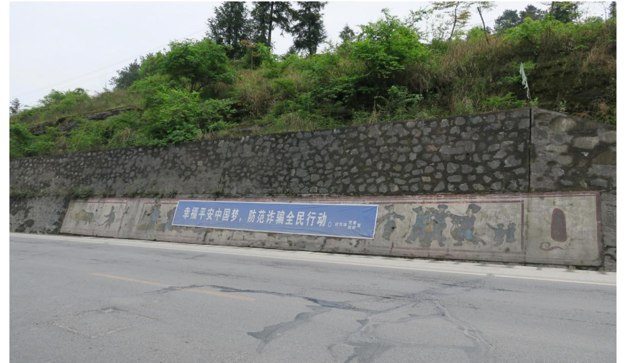
图 4-1-1 东库岸迳大公路开挖边坡高挡墙稳定
