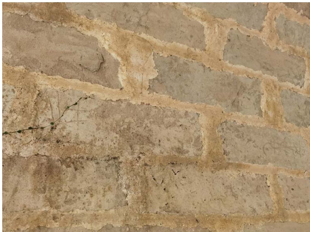
2、主拱圈右拱腰出现一条纵桥向裂缝，缝长约 1.5m，缝宽 2~4mm
