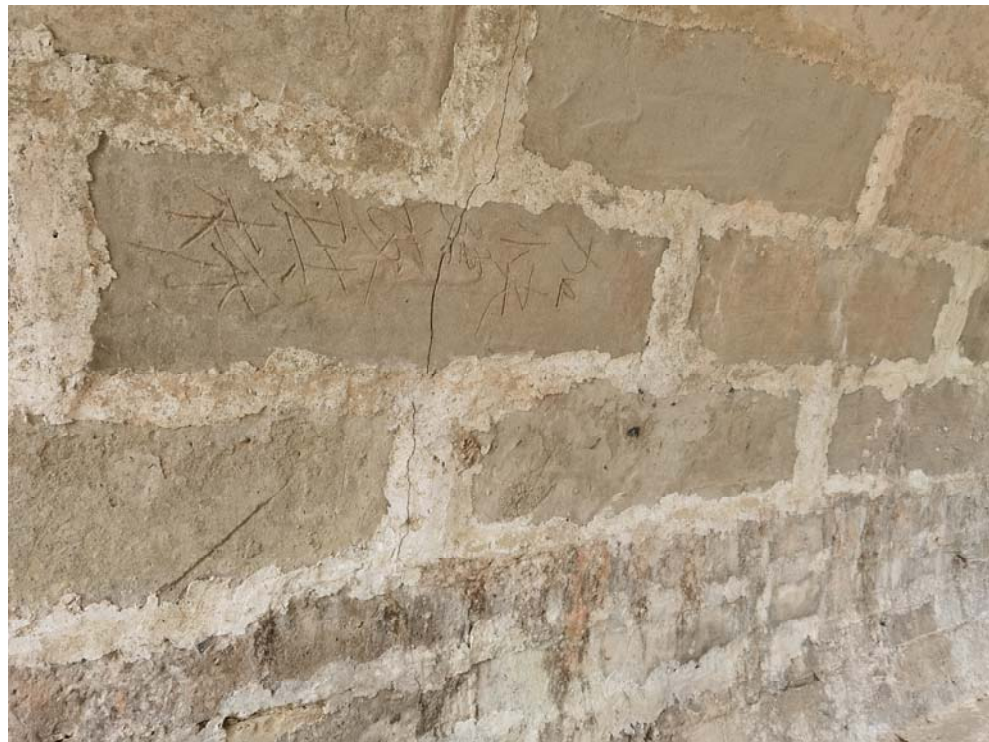
2、主拱圈右拱腰出现一条纵桥向裂缝，缝长约 1.5m，缝宽 2~4mm
