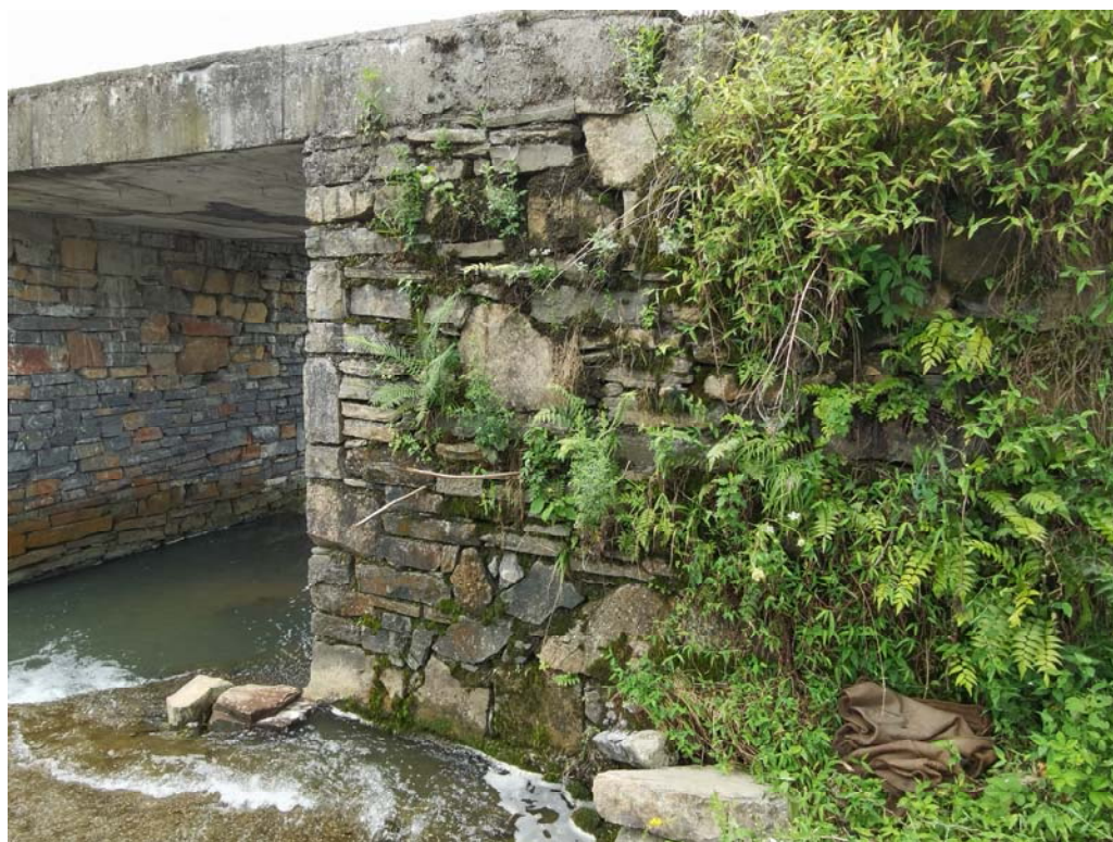
2、桥台纵向裂缝，缝长 3m，缝宽 2~3mm：
