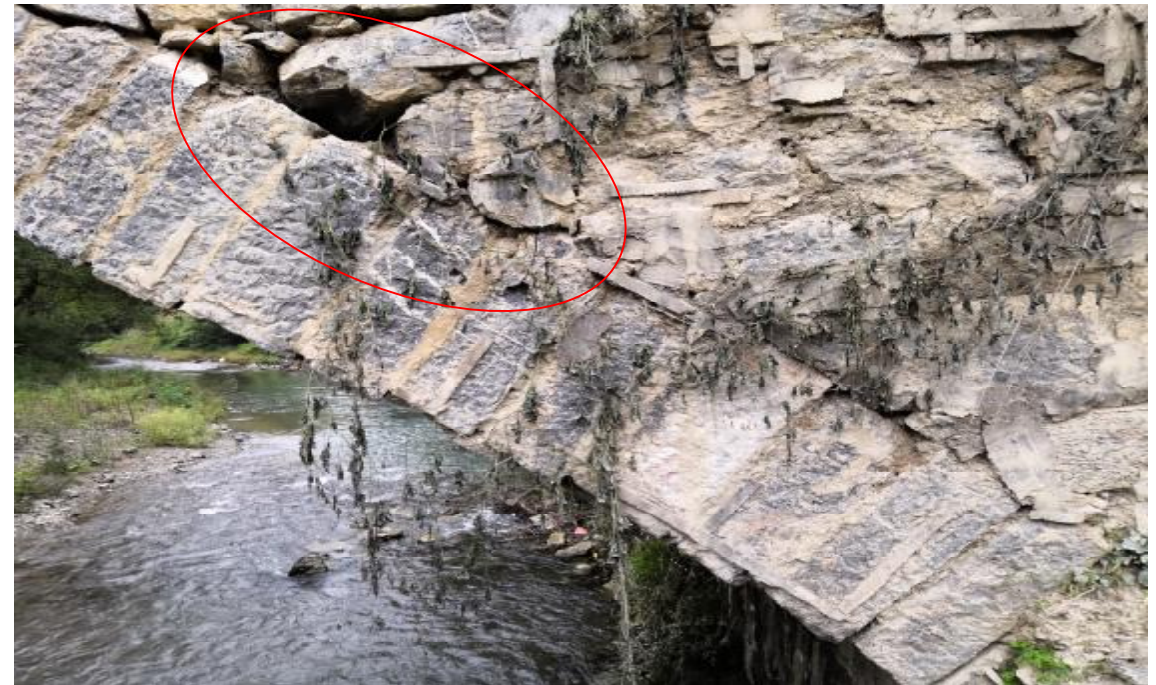
图 1-4 侧墙块石松动
